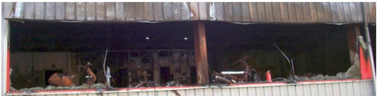
Gaisro padaryta žala dėl korozinių dujų
